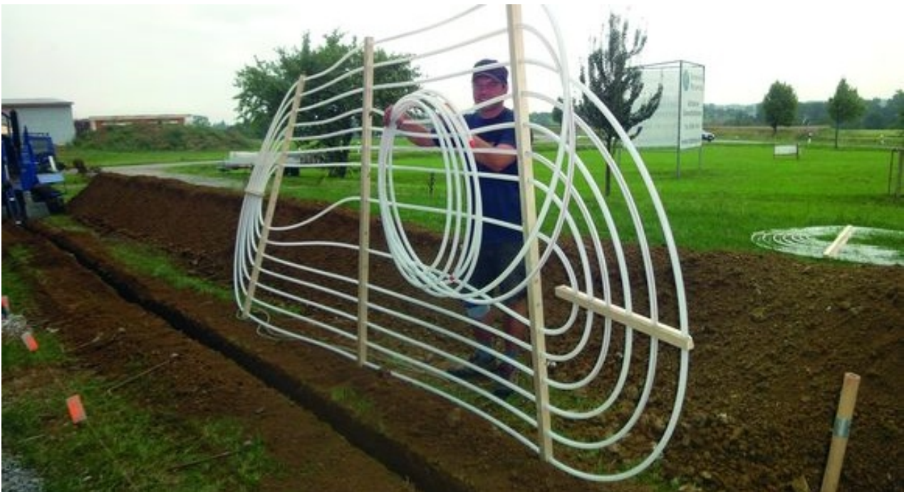
Mit neuartigen Rohrsystemen lässt sich Erdwärme platz- und kostensparend nutzen. © Steinhäuser GmbH & Co. KG
